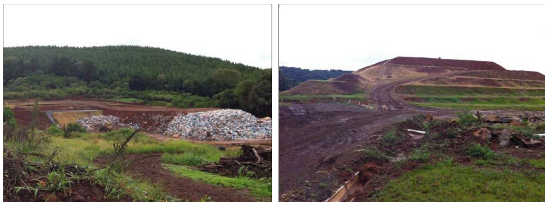
Figura 18 - Aterro Sanitário da Empresa Tucano Obras e Serviços Ltda. – Erval Velho SC.
