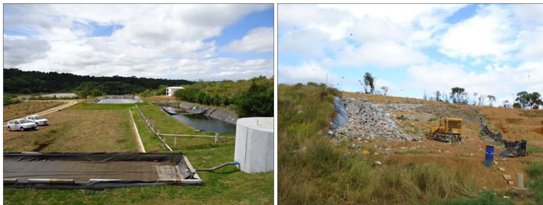
Figura 15 – Aterro Sanitário do Consórcio Intermunicipal do Contestado (COINCO) – Curitibanos SC.
