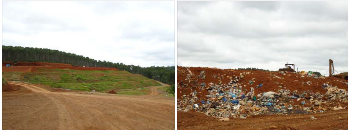
Figura 16 - Aterro Sanitário da Empresa VT Engenharia e Construções Ltda. - Fraiburgo SC.
