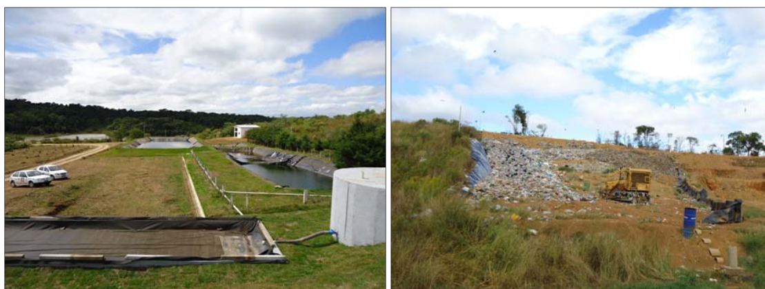
Figura 14 – Aterro Sanitário do Consórcio Intermunicipal do Contestado (COINCO) – Curitibanos SC.
